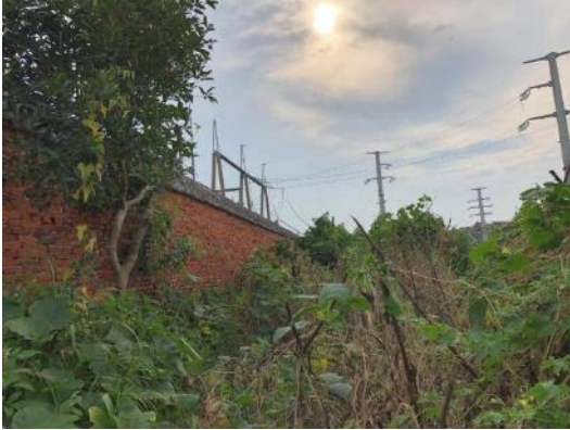
酿溪 110kV 变电站南侧厂界
