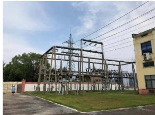
站内地面硬化及绿化
