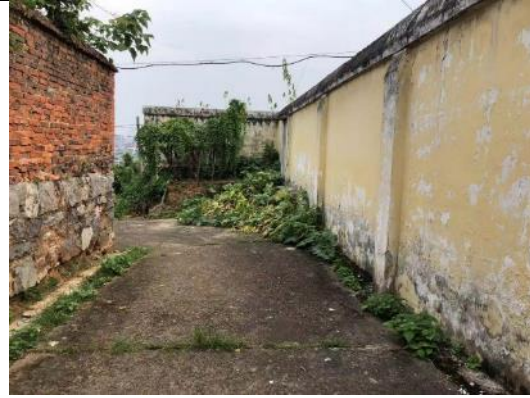
酿溪 110kV 变电站东侧厂界
