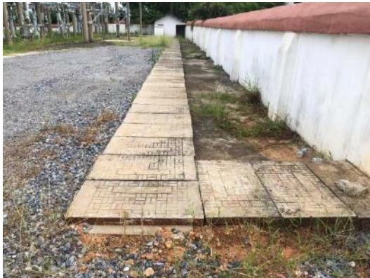
站内地面硬化
