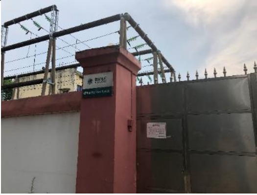
酿溪 110kV 变电站大门
