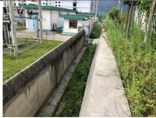
关峡 110kV 变电站西北侧厂界
