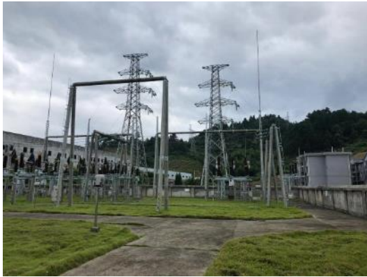
站内地面硬化及绿化
