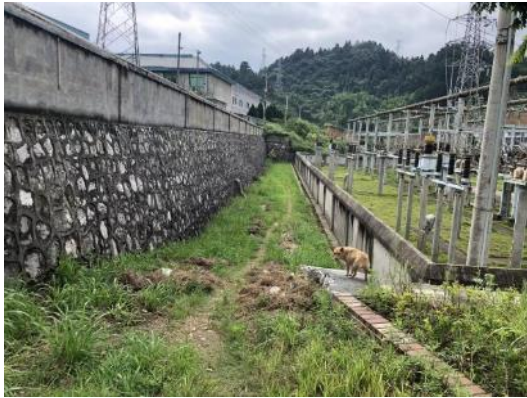
关峡 110kV 变电站东北侧
