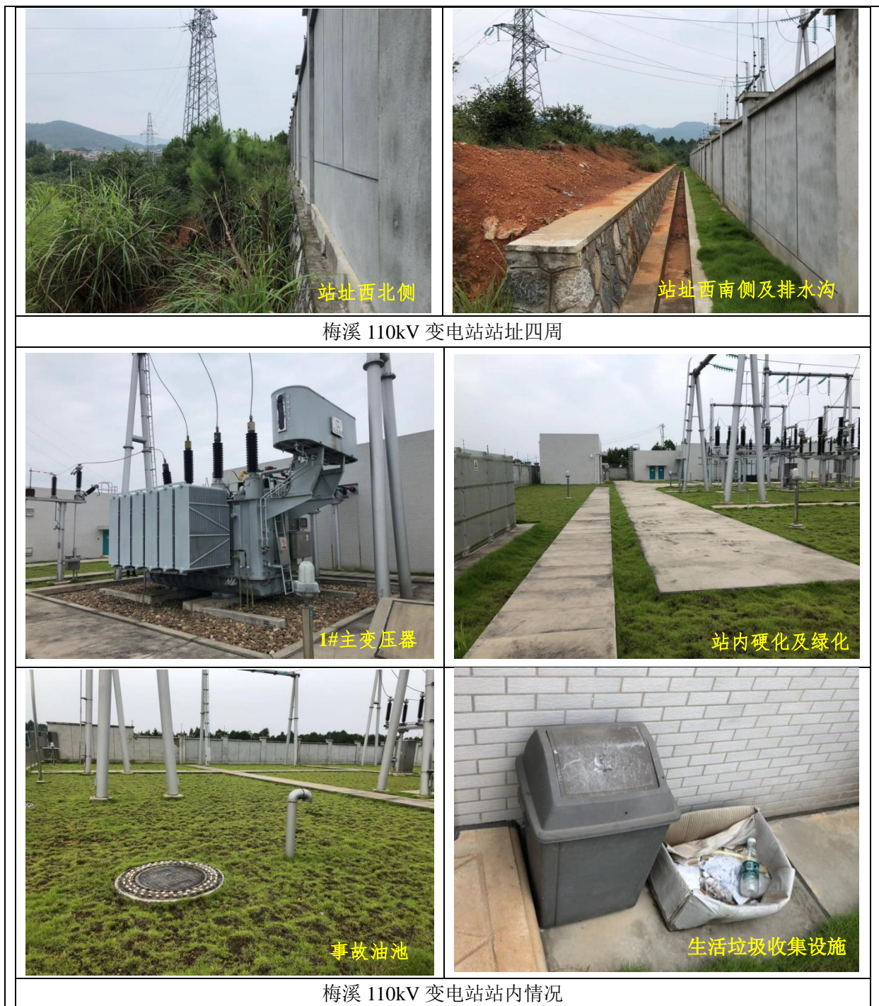
图 3-1 梅溪 110kV 变电站站内及周边环境现状
