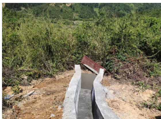
浆砌石排水沟
