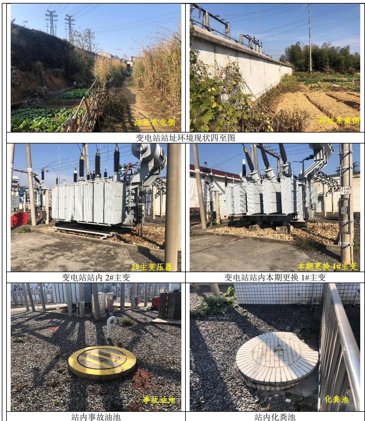
图 1 长寿 110kV 变电站区域自然环境及站内现状
