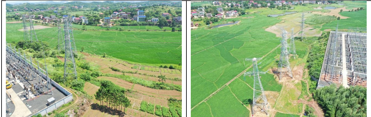
图 2 湖南衡阳衡东栗木 220kV 变电站 2 号主变扩建工程周边环境现状
