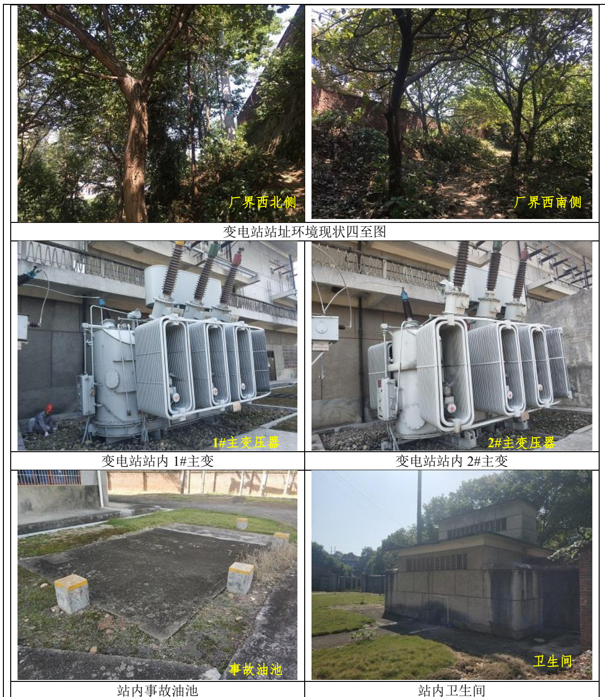
图 1 园珠岭 110kV 变电站区域自然环境及站内现状
