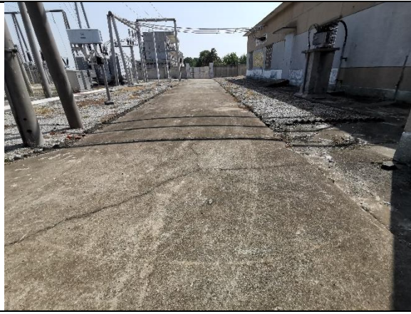
站内地面硬化
