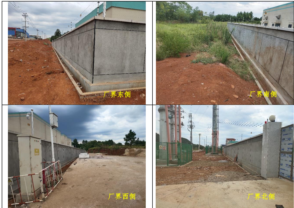
铸都（城北）110kV 变电站厂界四周
