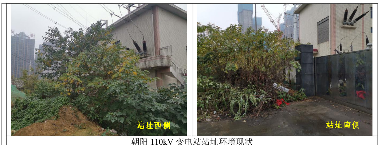
图 1 朝阳 110kV 变电站区域自然环境现状
