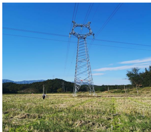
线路沿线情况
