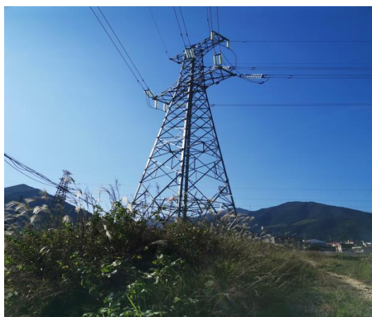
线路塔基恢复
