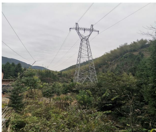
线路沿线情况
