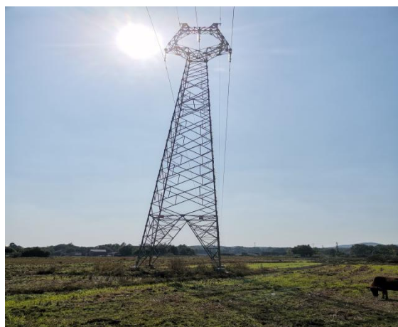
线路塔基恢复
