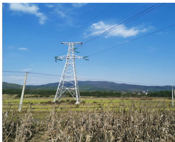
线路塔基恢复
