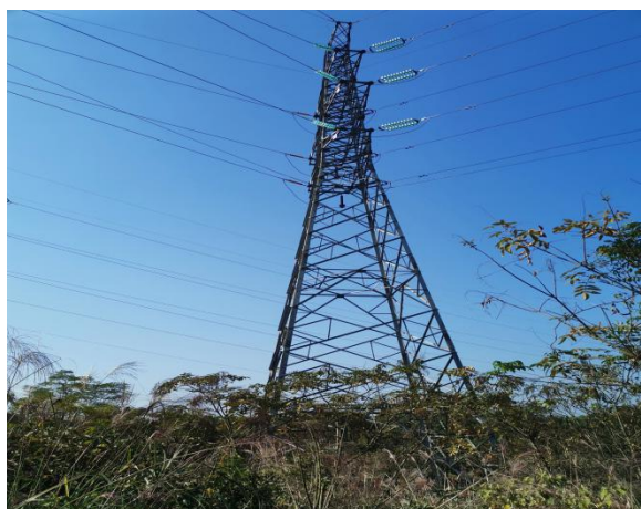
线路塔基恢复
