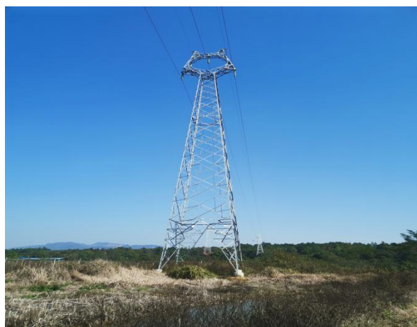
线路塔基恢复
