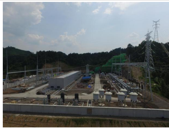
变电站外区边坡
