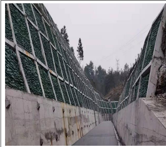
变电站外区边坡
