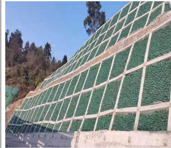
进站道路区边坡
