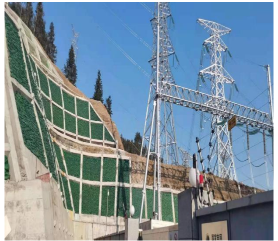
变电站外区边坡
