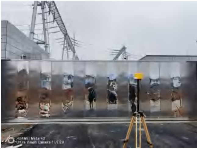
变电站厂界电磁环境监测
