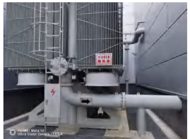
变压器散热器
