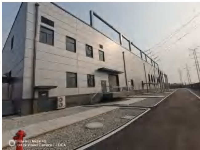
站内道路及场地硬化
