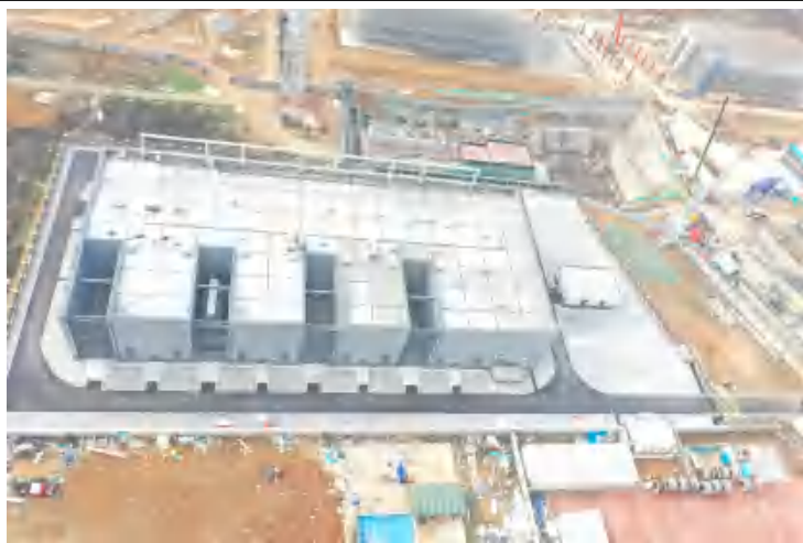
黄兴（鹿芝岭）220kV 变电站航拍总平图
