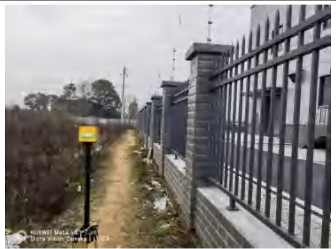
变电站北侧生态环境
