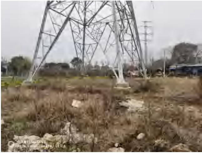
塔基植被恢复
