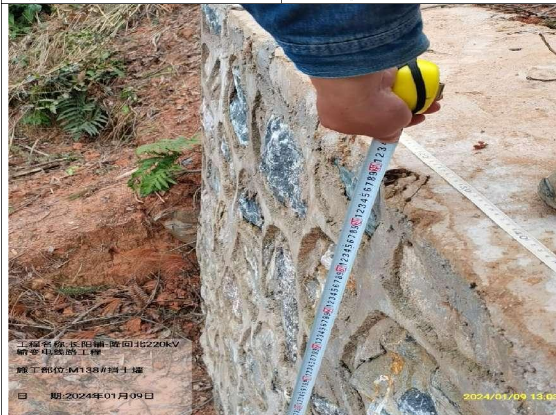
M138 现场测量挡墙
