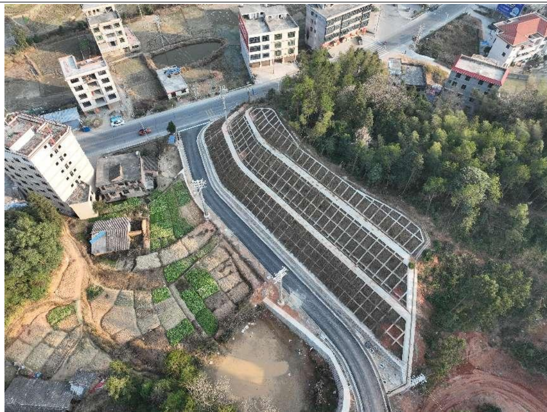
进站道路护坡
