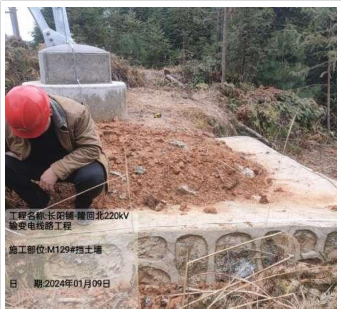
M129 塔基植挡墙测量
