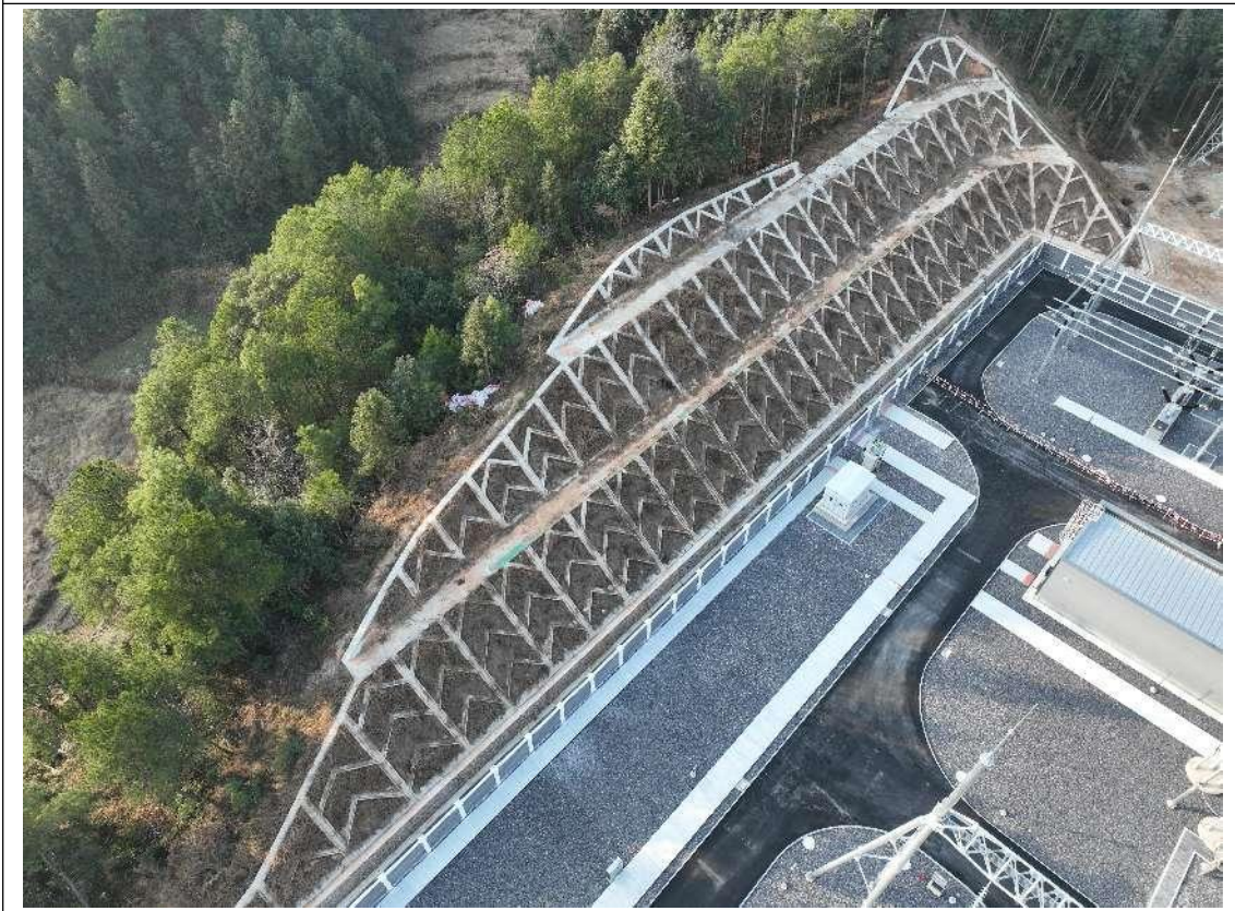
变电站站区骨架护坡
