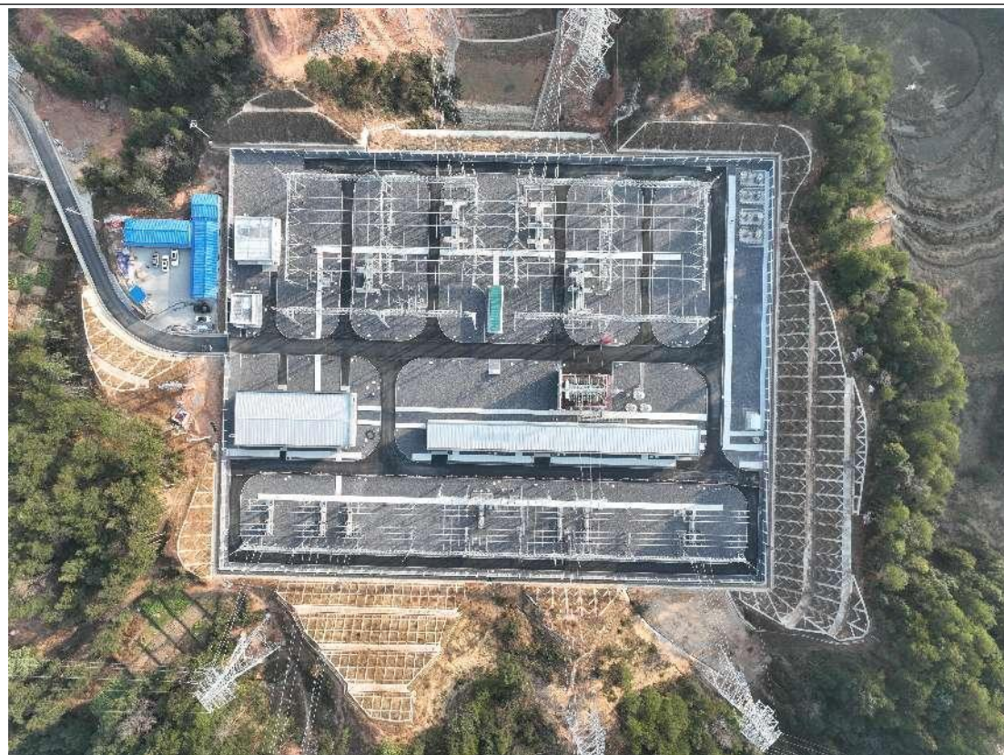
隆回北变电站正是航拍图（2023年12月15日）
