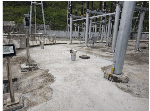
新建事故油池
