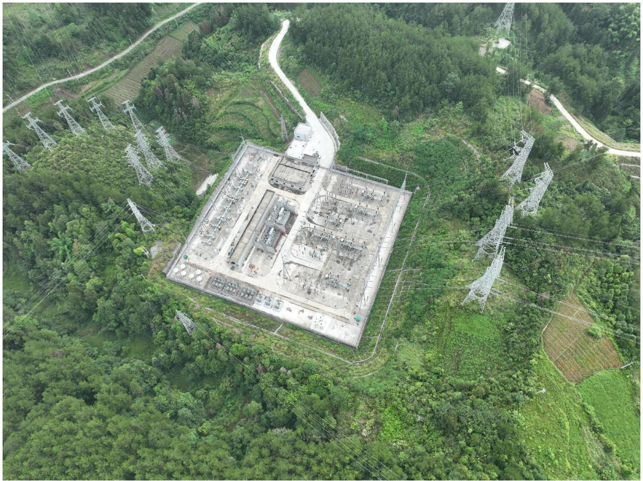
图 4-3 变电站周边环境情况
